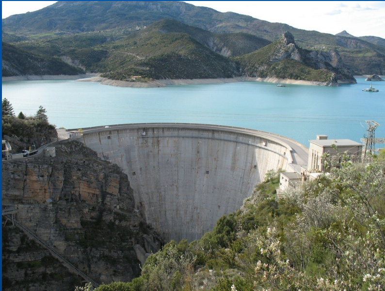
Verdon, Barrage de Castillon
